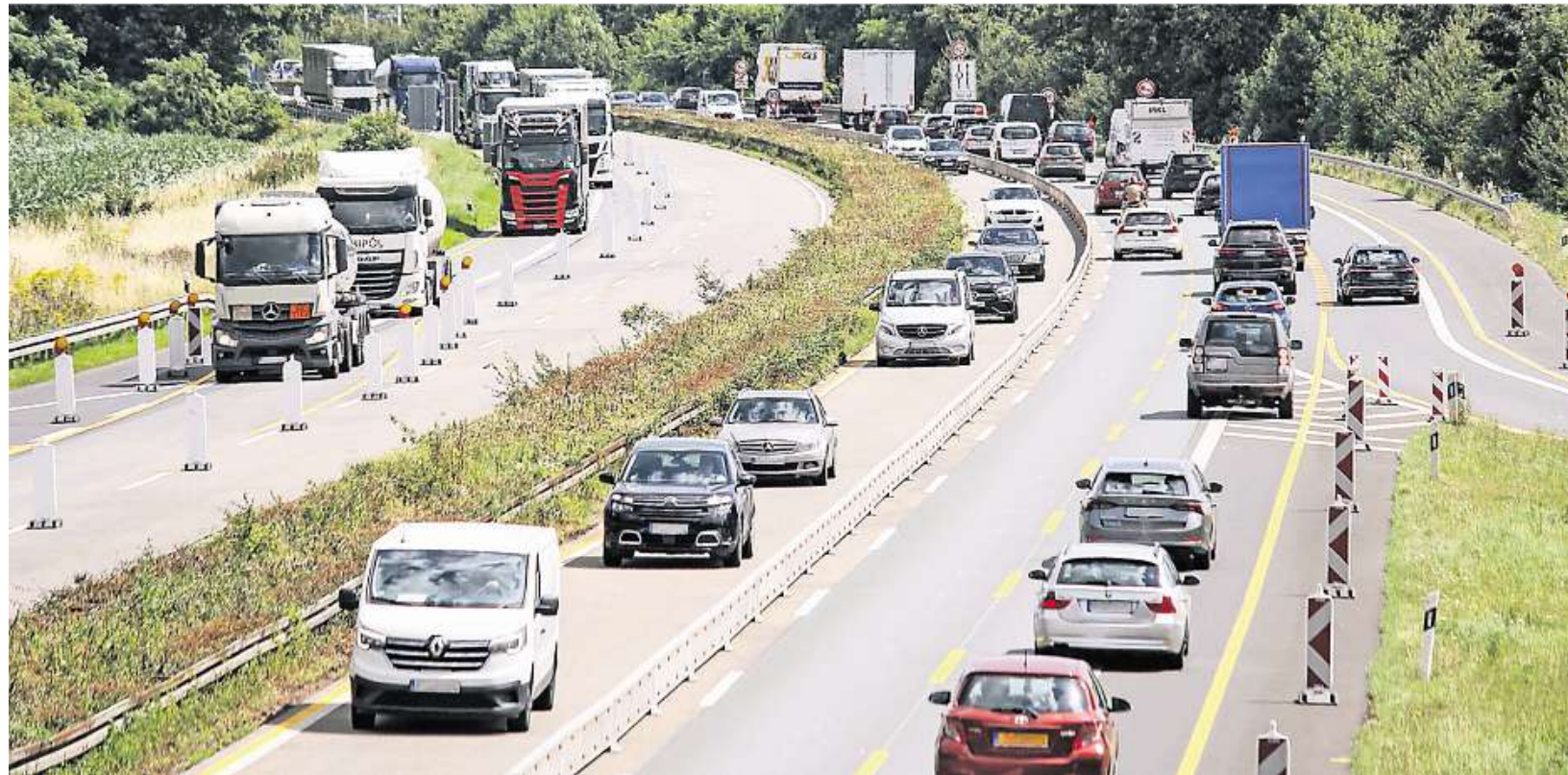
Ein Blick von einer Brücke an der Anschlussstelle Grevenbroich auf die Autobahn 46, die seit Juli 2024 eine Baustelle ist. Nun wird die Abfahrt Grevenbroich/Gierath für fünf Wochen gesperrt.
