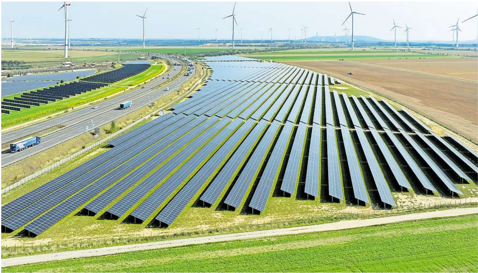
Das größte Projekt der BEH ist die Freiflächen-PV-Anlage „In der Dell“ mit einer Größe von drei Hektar. Hier ein Foto des RWE Solarparks am Tagebau Garzweiler.
